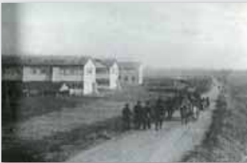
久留米工業専門学校 昭和16年。当初の校名は久留米高等工業学校といった。昭和19年、久留米工業専門学校と改称、昭和26年3月廃校となった。
