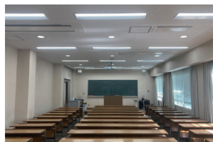
改修後（LED照明）
