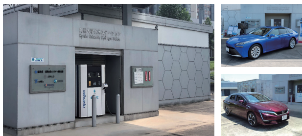
水素ステーション
