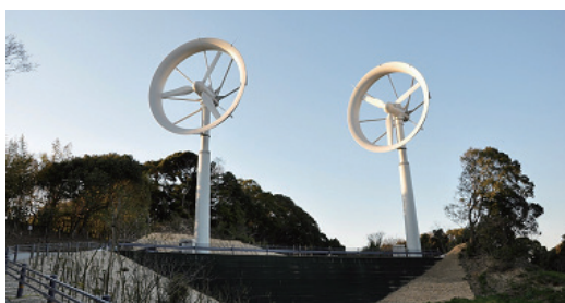
70kW×2 風レンズ型風力発電設備
