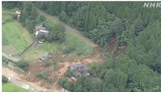
図-1 JR 日田英彦山線の土砂崩れによる被災状況 (2021 年 8 月 15 日)
