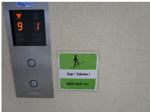
エレベーターのボタン付近に掲示
