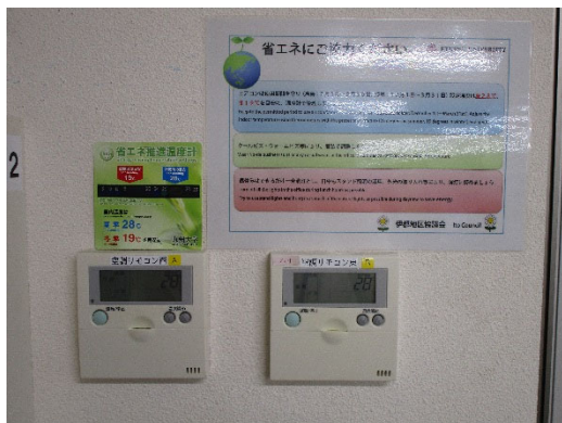
空調リモコン付近に省エネポスターの掲示
