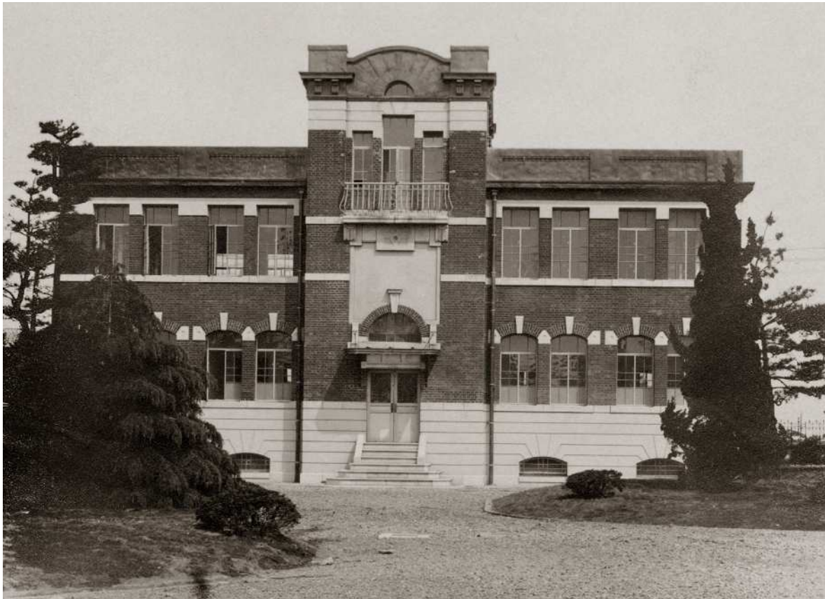
資料10 大正14年撮影 本部建築課棟落成直後写真 【九州大学大学文書館所蔵】 パラペット（屋上外周立上り）、バルコニー、玄関庇などはのちに改修され意匠が変更された。
