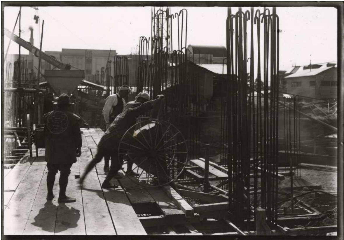
資料3 撮影時期不明 工学部本館建設中写真 【九州大学大学文書館所蔵】
