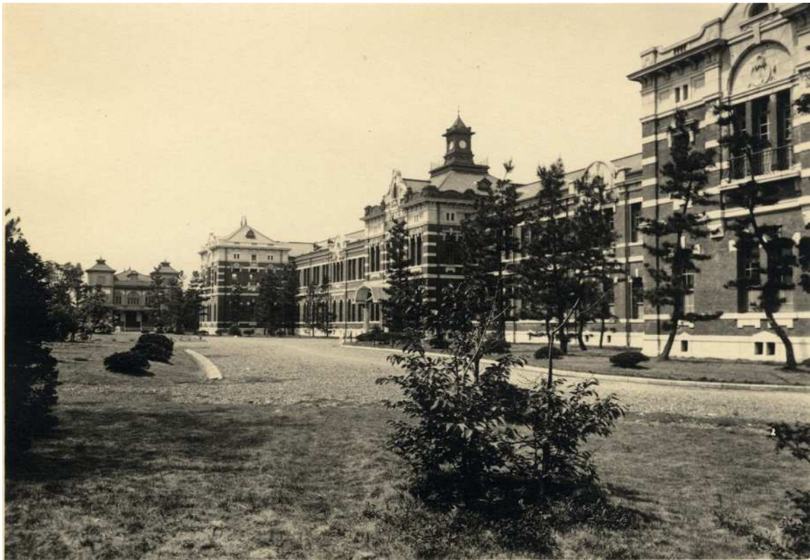
資料8 撮影時期不明 工科大学本館写真 【九州大学大学文書館所蔵】 大正12年に焼失したかつての工科大学本館。窓周りの装飾など石造りの部分を中心に、 本部事務室棟及び本部建築課棟へその意匠が引き継がれていることが見てとれる。
