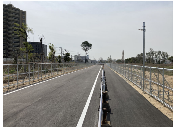
③ 仮設道路
