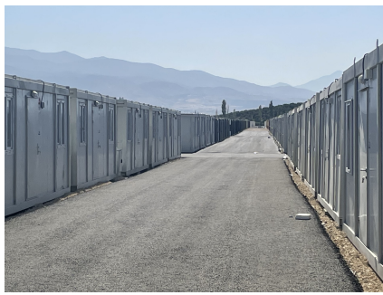
建設予定地のコンテナ型仮設住宅
