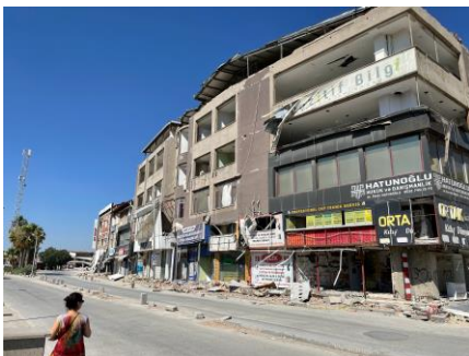
地震で破壊された街
