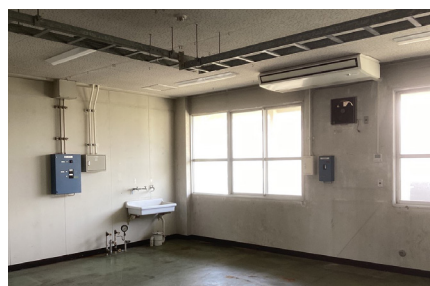
改修前（室外機）
