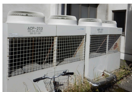
改修前（室外機）
