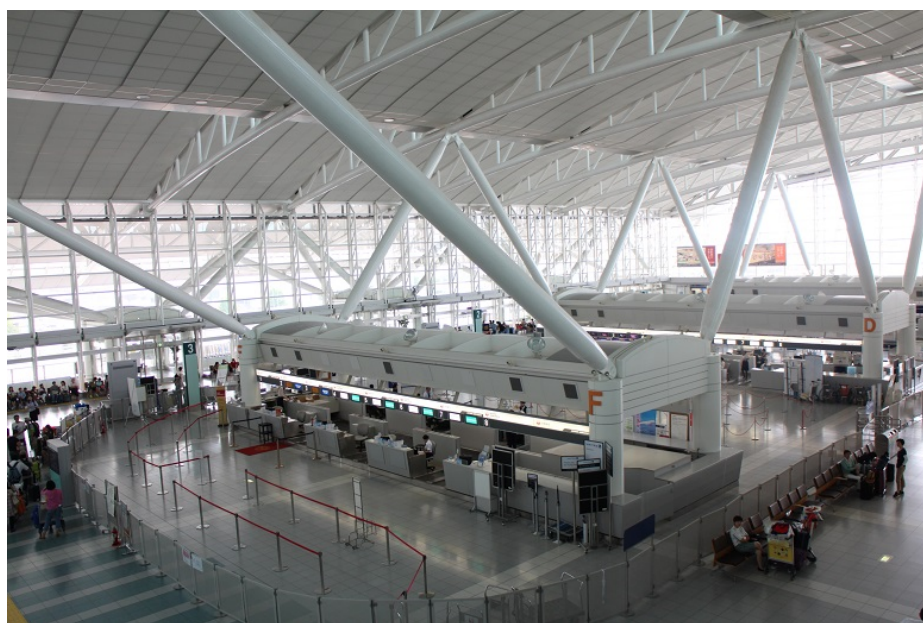
図3 国際線ターミナルの搭乗手続きエリア
