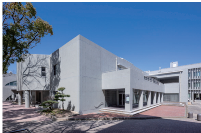
大橋地区：多次元デザイン実験棟 改修（2023 年度）
