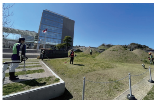
（写真8）建物周りの除草作業
