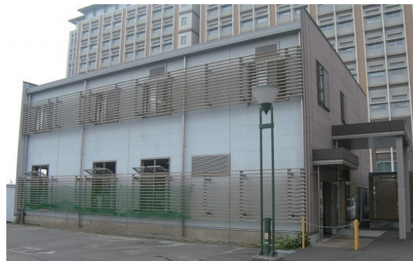
(写真 1) エコセンター
