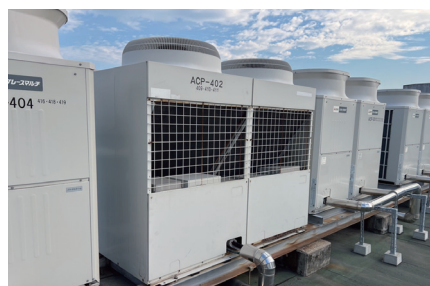
改修前（室外機）
