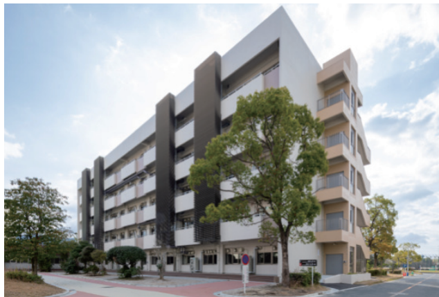
筑紫地区：総合理工学府研究院本館（D 棟）改修（2024 年度）
