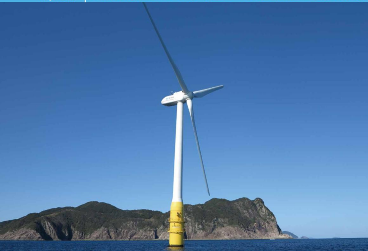
浮体式洋上風力発電施設
