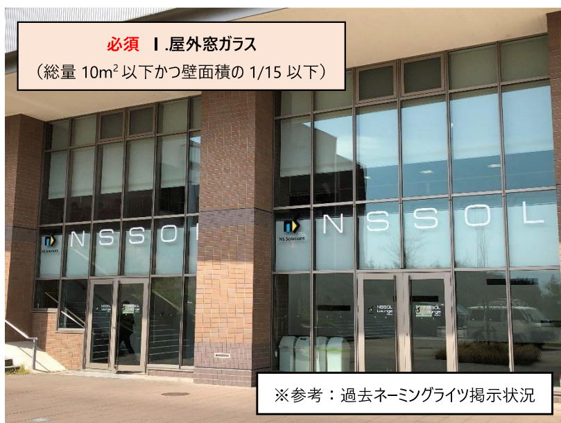
①-1：210 講義室 屋外側写真
